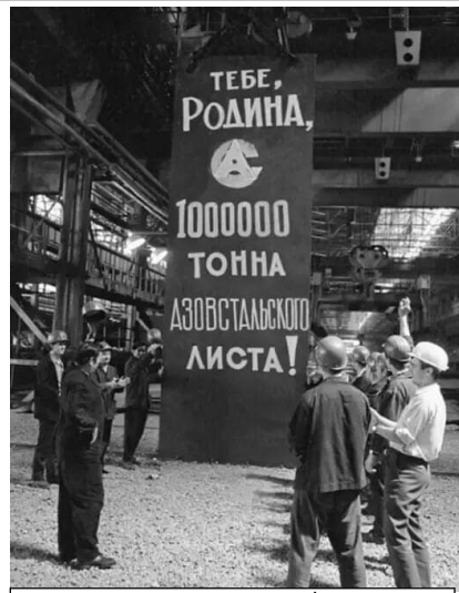
Фотохроника ТАСС. Работники завода во время сдачи миллионной тонны проката, 11.08 1974 года.
